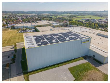
Allein 2023 hat das Unternehmen Photovoltaik-Anlagen mit einer potenziellen Jahresleistung von 1.400.000 kWh auf seinen Gebäuden installiert, hier auf dem Dach des Logistikzentrums in Obersontheim.
