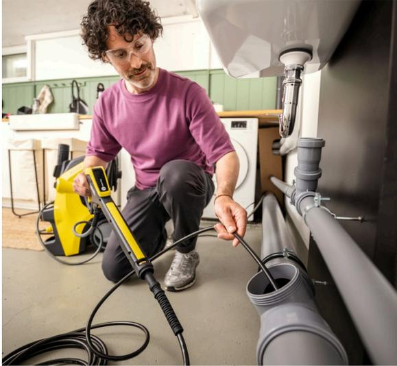
*Während die rotierende Düse für einen 360°-Reinigung der Rohrwand sorgt, eignet sich die Jet-Düse mit starkem Vortrieb insbesondere bei verstopften Rohrleitungen.*
