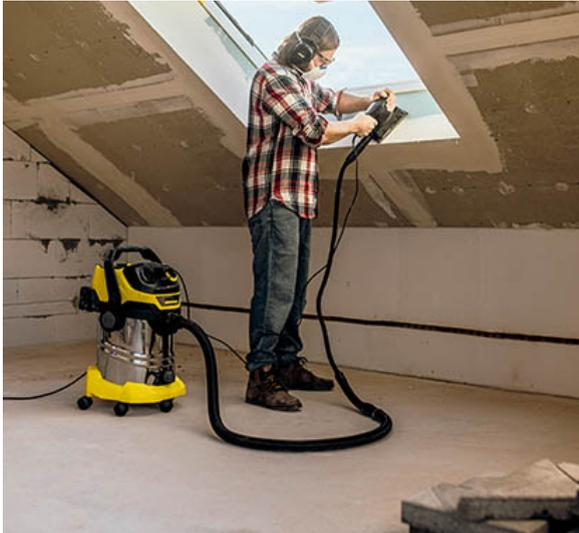
*Mit einem passenden Adapter kann der Saugschlauch des Nass-/Trockensaugers direkt mit verschiedenen Elektrowerkzeugen verbunden werden. Der entstehende Schmutz wird dann direkt abgesaugt und gelangt nicht in die Raum-/Umgebungsluft.*
